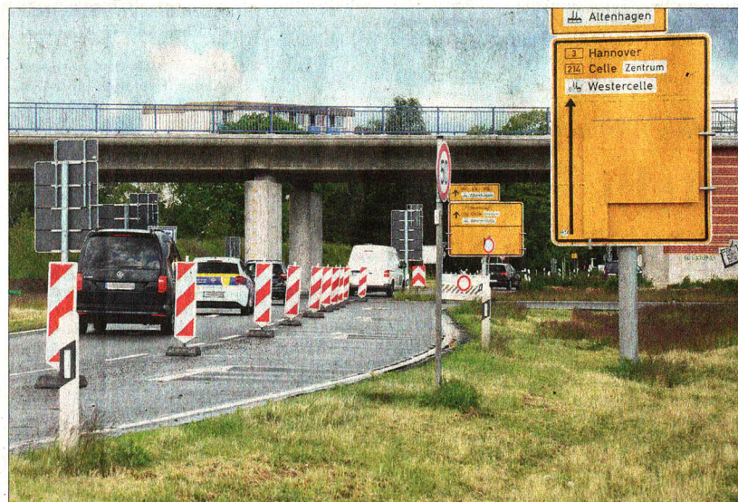
Zur weiteren Verbesserung der Infrastruktur im Landkreis gehört auch der Bau der Celler Ortsumgehung. Henning Otte freut sich, dass jetzt die Durchfahrt durch die neugebaute Brücke möglich ist.
