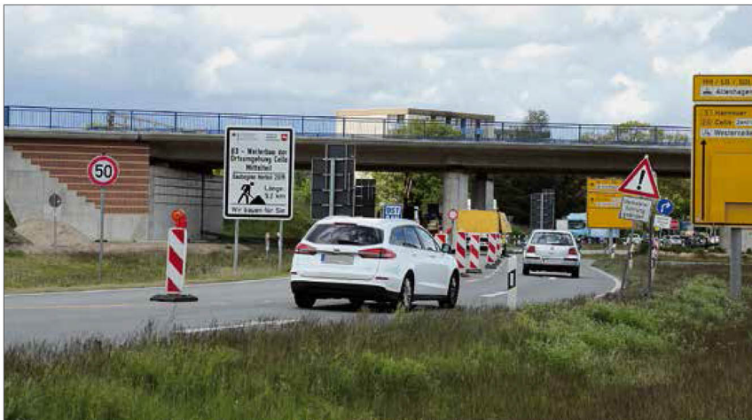
Die Brücke über die B 214 ist fertiggestellt.
