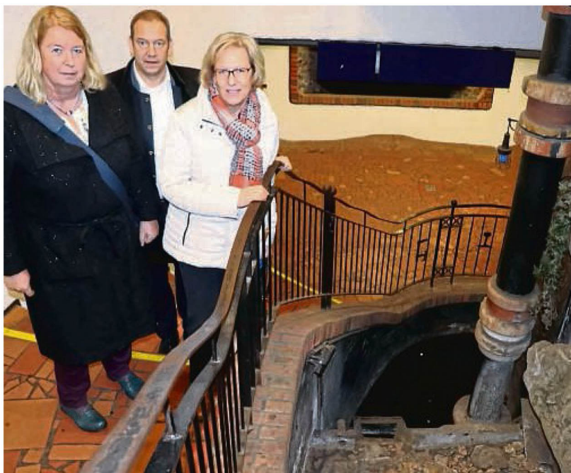
Wasser sprudelt hier zurzeit keines: Am Ausgang vom Tunnel zur Bahnhofshalle ist das 2004 entstandene Wasserspiel nicht in Betrieb. Bärbel Aissen von der DB, CDU-Politiker Henning Otte und die Uelzenerin Roswitha Machel verschaffen sich einen Eindruck. FOTOS: REUTERS
