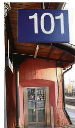
Kaum neu eingebaut, schon wieder kaputt: der Fahrstuhl am Gleis 101.
